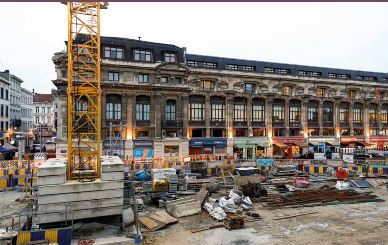
Le chantier du Métro 3 à l'avenue de Stalingrad, hiver 2022.
